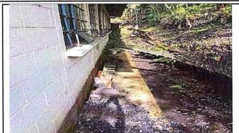
Foto 2: se puede observar que el espacio entre muro y tierra es bastante pequeño; por lo que con las lluvias que se presentan en estas fechas, el muro no soportará el peso hasta caerse totalmente.
